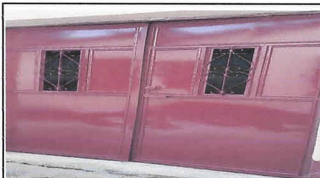
Foto 4: Mantenimiento y cambio de chapas del porton del salon.
