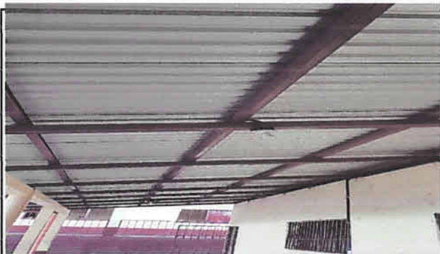
Foto 3: Cambio de techado del corredor.
