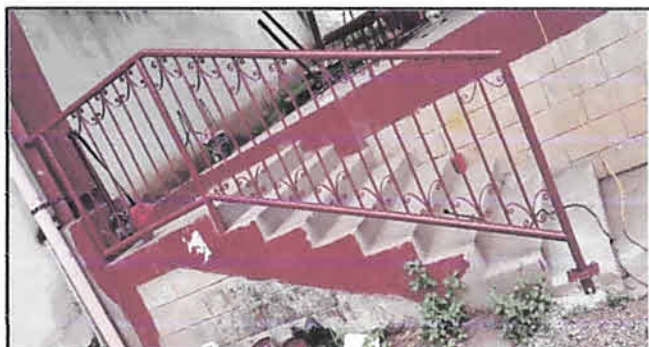
Foto 6: Mantenimiento de baranda del escenario.
