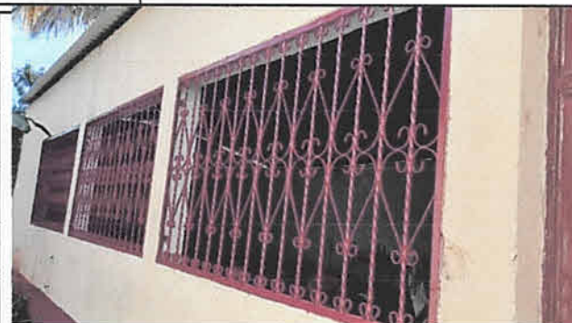
Foto 2: Mantenimiento a balcones.
