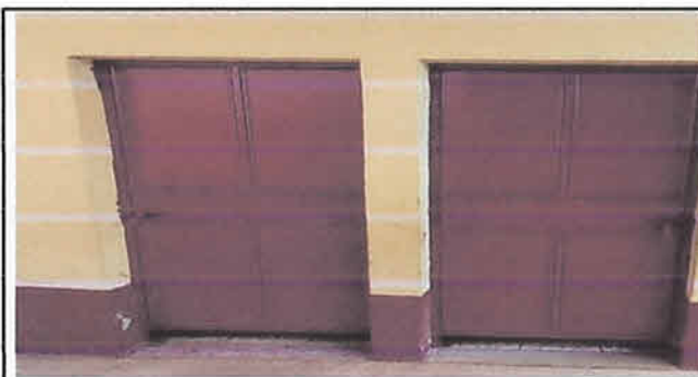
Foto 5: Reparacion y mantenimiento de las puertas del baño.
