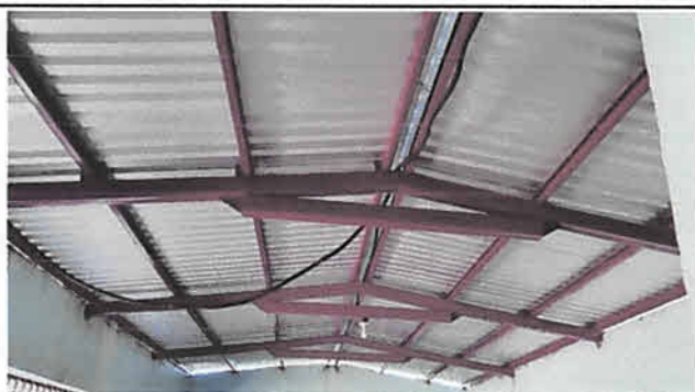
Foto1: Mantenimiento de estructura y cambio de techado.
